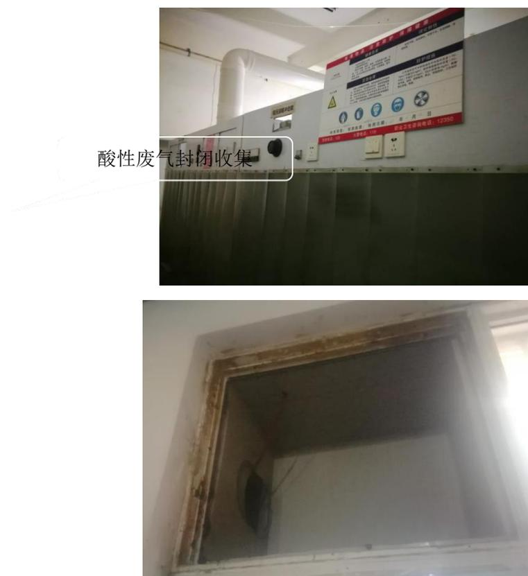
图 12 电镀酸洗废气收集设施及全封闭废气出口
