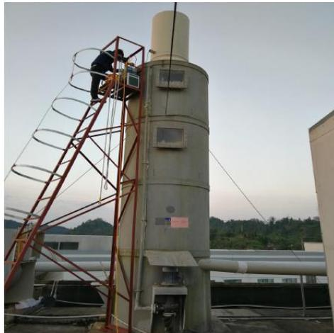
图 14 TW600 电加热水雾喷淋器
